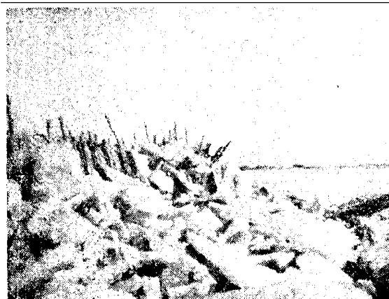
圖一 四千餘萬立方公尺的積冰，積滿了四十多華里的黃河河道，巨大體積的冰塊，爬上了稽埽、堤頂，造成黃河決口前的嚴重形勢。
