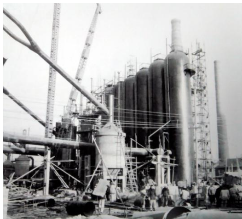
图1 1959年钢铁试验厂建起 55\text{m}^3 高炉等设施(图片来源:包钢画册(1954-1984), 1984)
